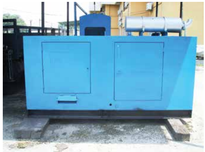
Generator Set Kohler (60 KVA) untuk ujian pengepaman Kohler (60 KVA) Generator Set for pumping test
