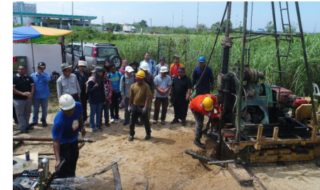
Penggerudian sedimen teras Projek Kajian Delta Sg Kelantan
