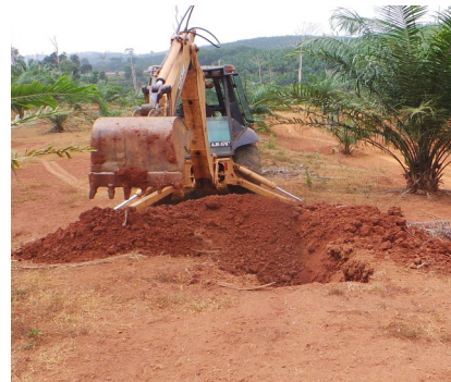
Menggorek lubang persampelan menggunakan jengkaut di Felcra Bt. Segumpal Maran, Pahang
