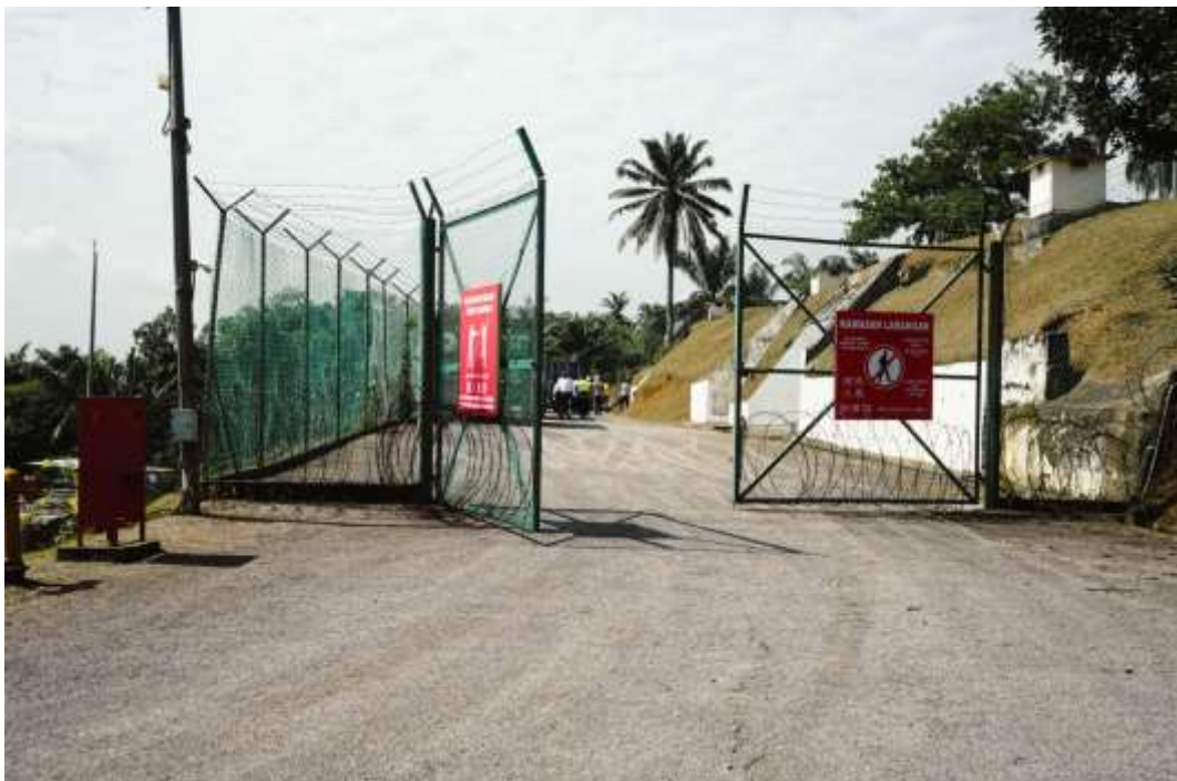
Gambar 2: Pintu masuk utama dan pagar berduri di sekeliling kawasan magazín
