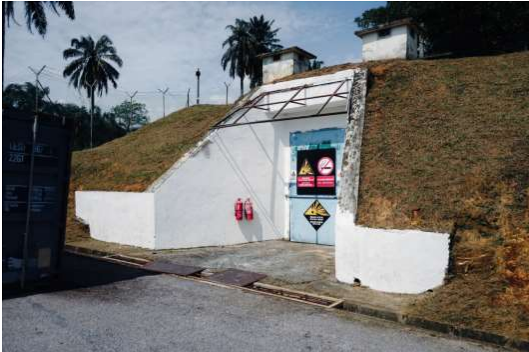
Gambar 3: Pintu besi magazin bahan letupan dilengkapi dengan papan tanda dan kunci mangga. Terdapat cerobong udara untuk sistem ventilasi di bahagian atas magazin
