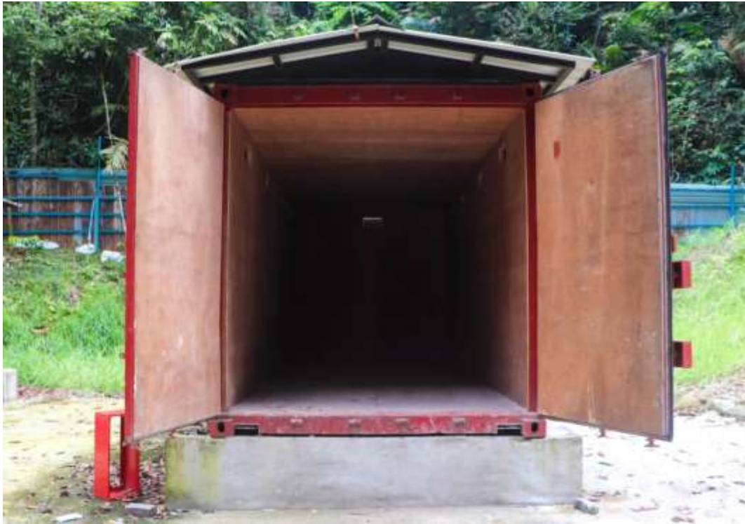
Gambar 11: Ruang dalam magazin mudah alih yang dilapik dengan kayu
